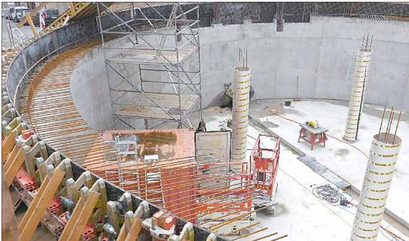
Bau Regenrückhaltebecken Hohetorstraße/ Katharinenstraße
