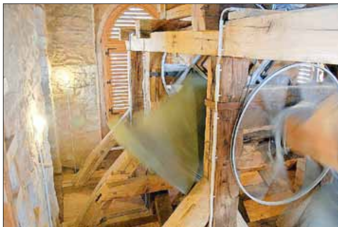
Wiederinbetriebnahme des Glockengeläutes
